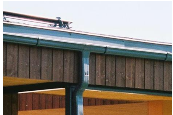
Bild 2. K13 ränna och stuprör
