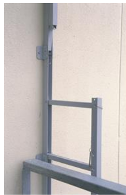
Bild 3. Stegen utfälld vid förlängningen
