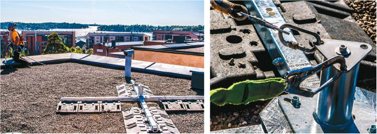
Kuva 1. Vastapainoankkuri, paino 374 kg
