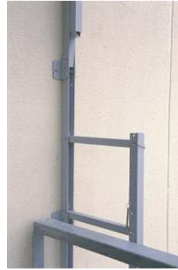
Kuva 3. Tikas aukaistuna jatkoksen kohdalla
